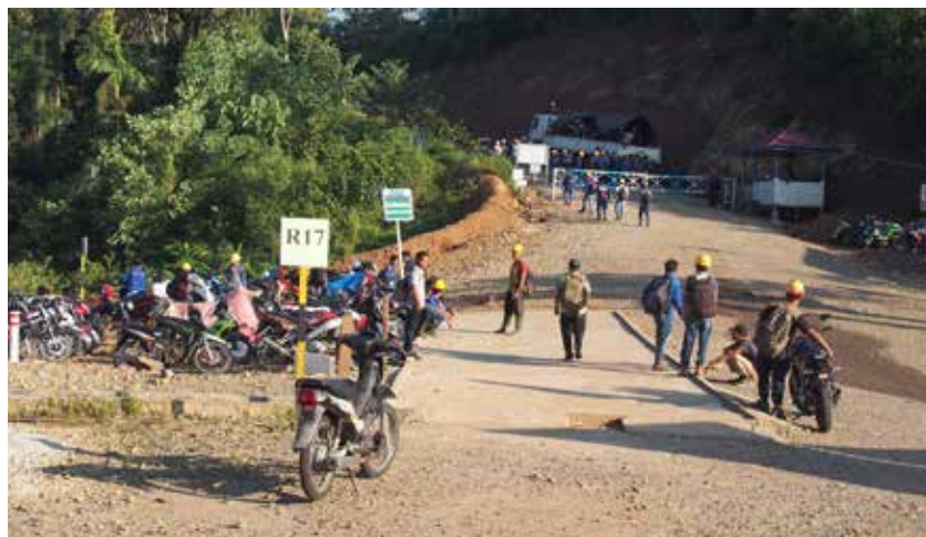
図4 タパヌリ地方の水力発電ダム建設地（地元の人々が一時的に雇用される労働者として、バイクで工事現場に通ってきている）※黒鳥英俊（NPO 法人日本オランウータン・リサーチセンター代表）が2019年2月に撮影
