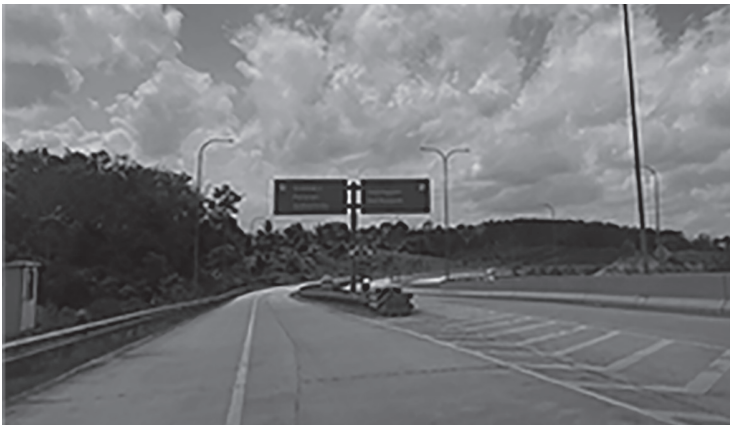
写真 2：港湾都市バリクパパン市と州都サマリダ市をつなぐ高速道路：この高速道路の開通により両市間の移動は 2 時間へと大幅に短縮された (2023 年 8 月、井上真撮影)
