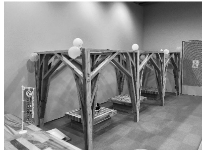
写真9 レシプロカル架構をイメージして組み立てられた「木もれびの部屋（ミニビレッジプラザ）」＝いずれも秋田県大館市提供
