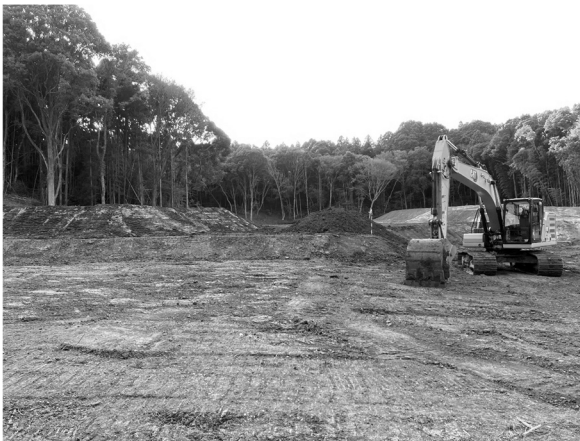
写真3 埋め立てられる谷津＝筆者撮影
