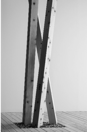
写真6 3本の斜柱からなる組柱 ＝エスエス撮影
