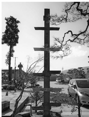
写真1 千曲川大洪水水位標。2019年の穂保破堤地点から約100m下流左岸堤沿いの妙笑寺にある。同年の氾濫水位（推定値）は過去2番目の高さである＝長野市、野池元基撮影。
