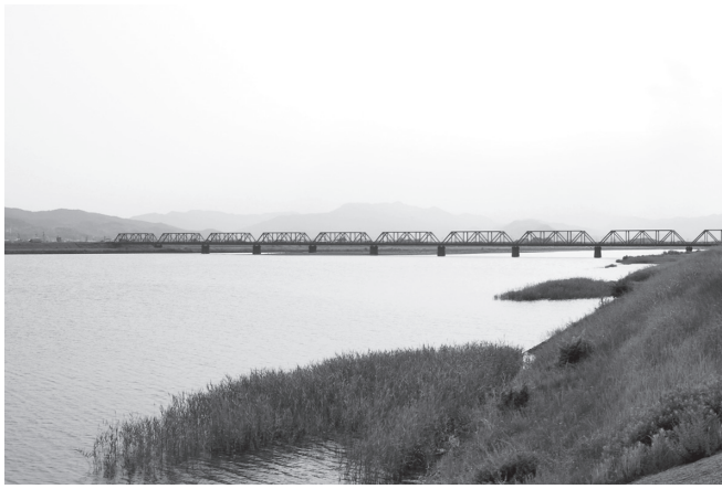
図5 現在の中島浦 かつて、材木を組んだ筏や、薪炭などを積んだ高瀬船が到着した、那賀川河口。現在の護岸はコンクリートの堤防で固められている。
