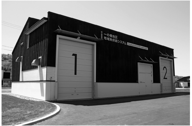
地域熱供給システム（ボイラー）
