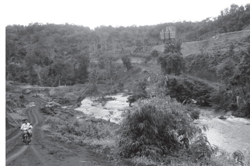
水力発電ダムの堤防建設地
