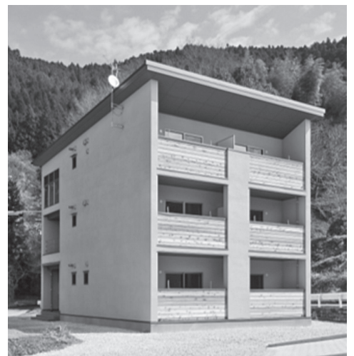
CLT 建築の国内第1号物件。製材会社の社員寮として建てられた
