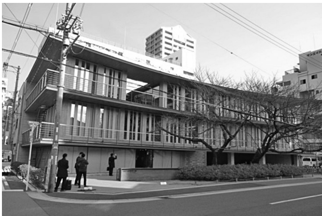
3階建ての大阪木材仲買会館。2～3階が耐火木造となっている
