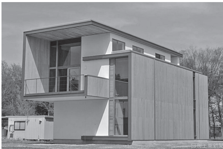
CoCo CLT（つくばCLT実験棟）。日本CLT協会がCLTの性能や施工性を調べるために建てた
