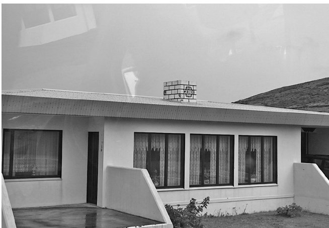
1972年に新築され、翌年の噴火の火山灰に埋まり全壊したものの、1980年に再建された住宅=写真はどちらもアイスランド・ヘイマエイ島火山博物館にて、筆者が2017年8月27日撮影
