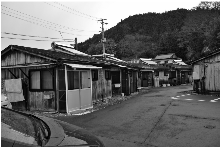
岩手県住田町の木造仮設
