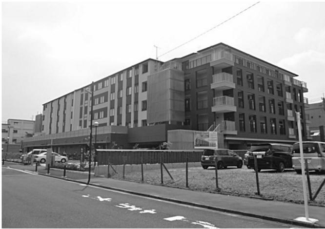
特別養護老人ホームの足立新生苑。木造（ツーバイフォー工法）による耐火5階建て構造（1階はRC造）となっている
