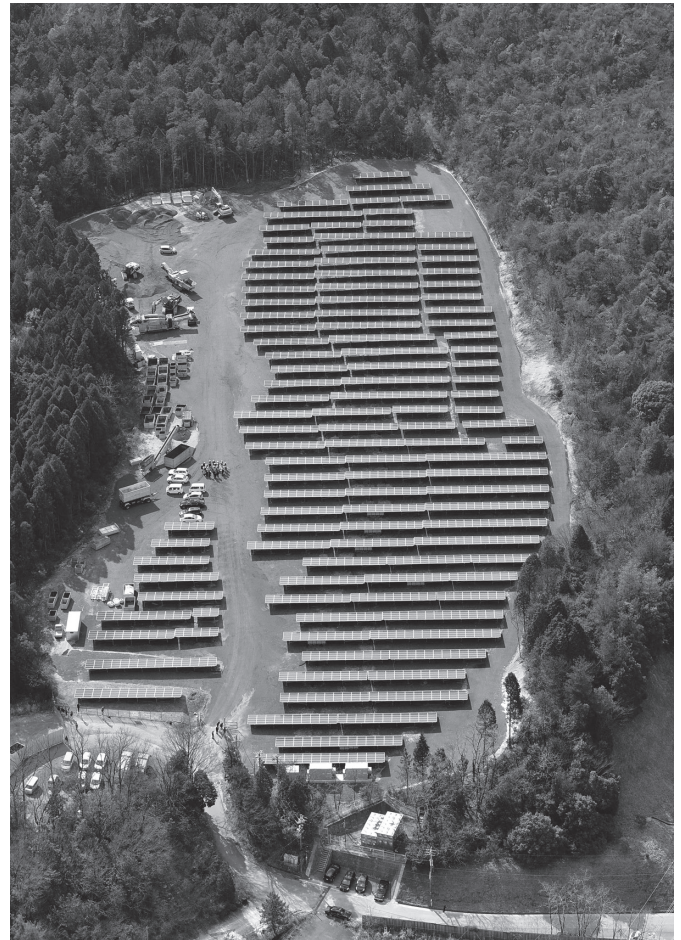
海上の森に隣接する林を伐採し設置されていた太陽光発電施設＝2016年2月、愛知県瀬戸市海上町
