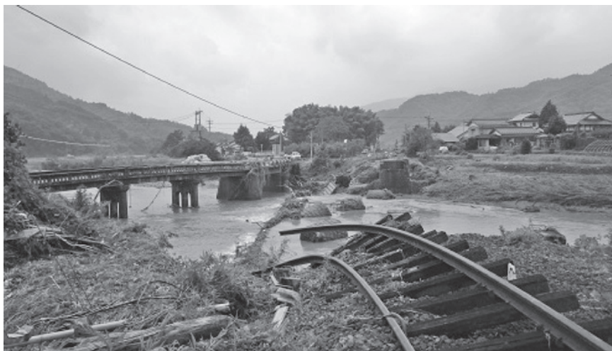
写真3 2013年7月の山口・島根豪雨で倒壊したJR山口線の鉄道橋
