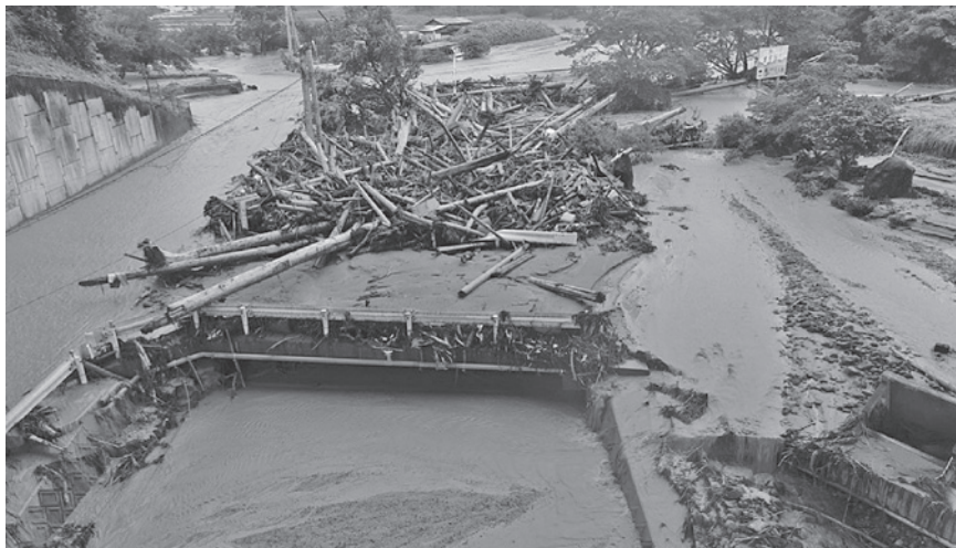
写真2 白木谷川で見られた道路橋への流木の集積
