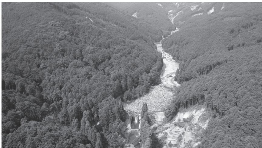
写真5 妙見川の須川第1砂防堰堤に捕捉された多くの流木
