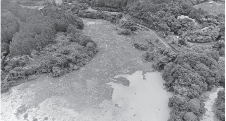
写真 4 寺内ダムのダム湖内に流入した流木
