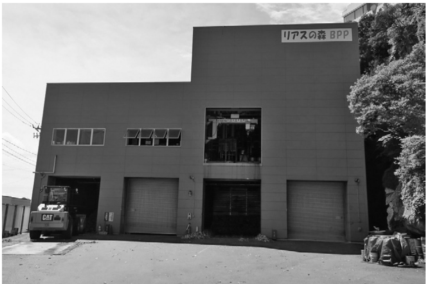
写真1 リアスの森バイオマスパワープラント（宮城県気仙沼市）の外観
