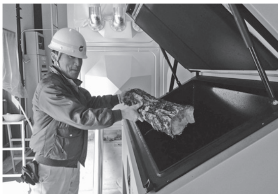
写真1 芸北オークガーデンの薪ボイラー（撮影：河野弥生）
