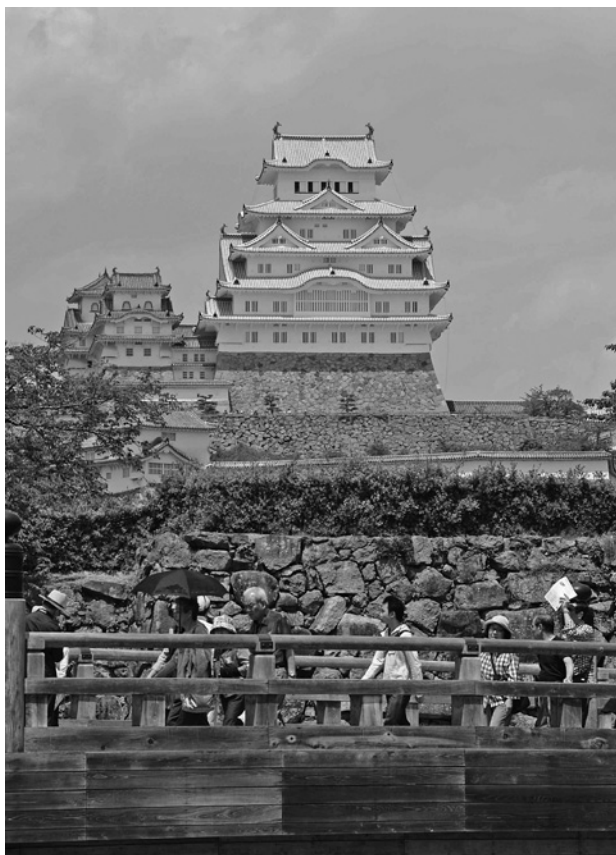
写真5 姫路城の天守閣。「平成の大修理」を終えたばかりだ
