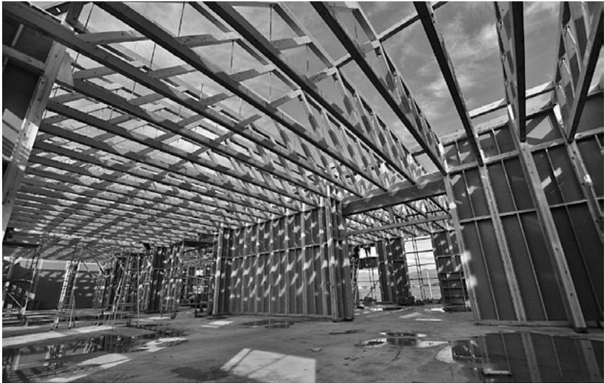
写真1 地域工務店による住宅用製材を用いた工場建築（2013年／福井県）
