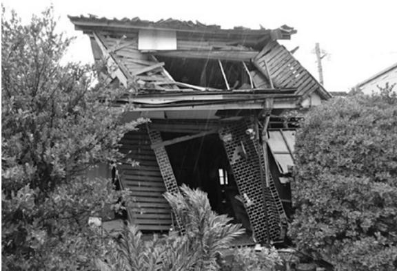
写真2 1、2階共に大きな残留変形があり倒壊寸前の古い木造住宅
