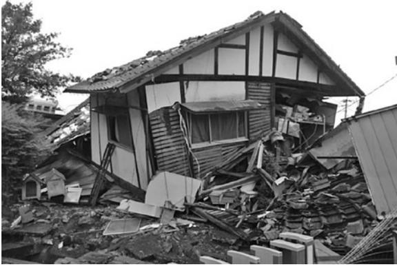
写真1 1階が倒壊した古い木造住宅
