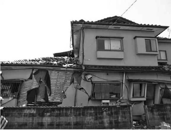
写真3 1階が傾いた新耐震基準以降の木造住宅
