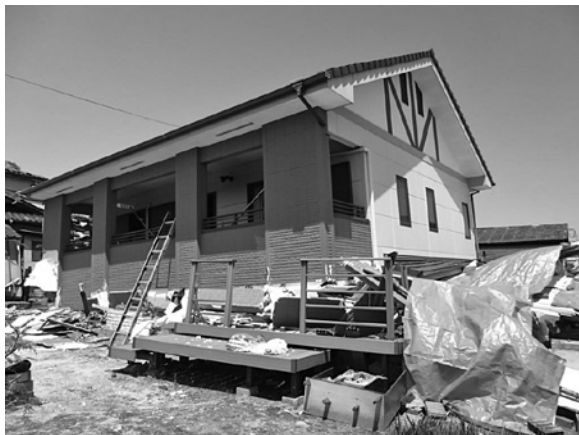
写真5 2000年以降に建てられた木造住宅の倒壊
