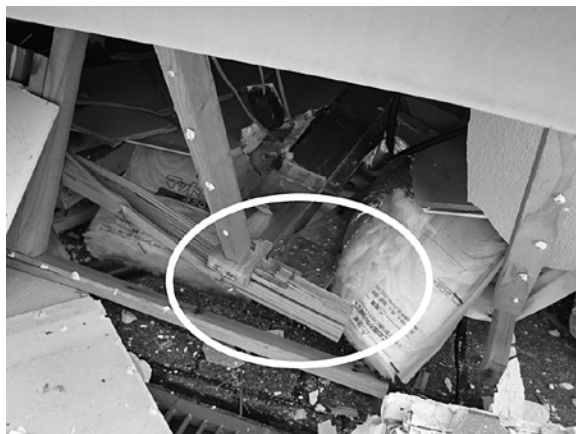
写真6 きちんと金物が留め付けられていた接合部
