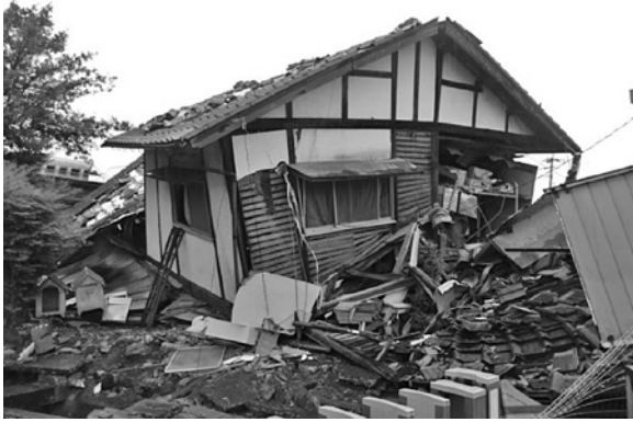
写真1 1階が倒壊した古い木造住宅
