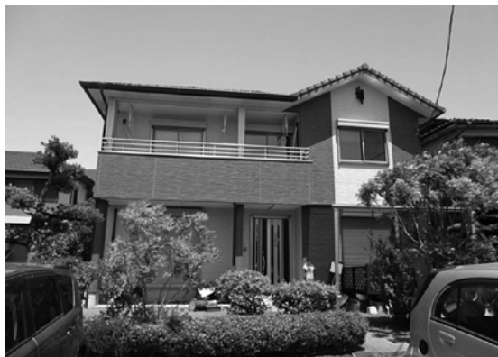
写真7 外観上無被害の木造住宅
