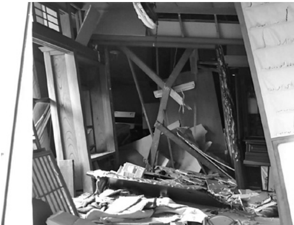
写真4 座屈して折れてしまった筋かい耐力壁
