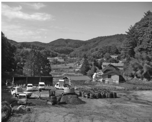
写真1 除染が進む里地の状況(2015年10月、川俣町山木屋地区)
