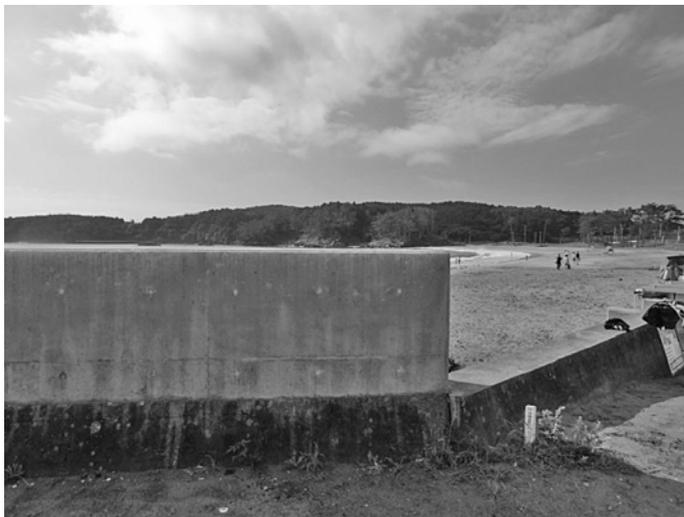
写真2 宮城県気仙沼市気仙沼大島にある小田の浜。住民の猛反対によって、宮城県の示した11.8mの防潮堤が原形復旧(3.5m)に留められた数少ない事例。ただし、県は地盤沈下を理由に1mのかさ上げを求めており、かさ上げする場所や方法などをめぐって、2015年8月現在、合意はできていない。写真のように、すでに部分的にかさ上げされた箇所があるが、道路からは海が見えなくなる。小田の浜は、環境省の快水浴場百選に選ばれ、国立公園第二種特別地域に指定されている(筆者撮影)
