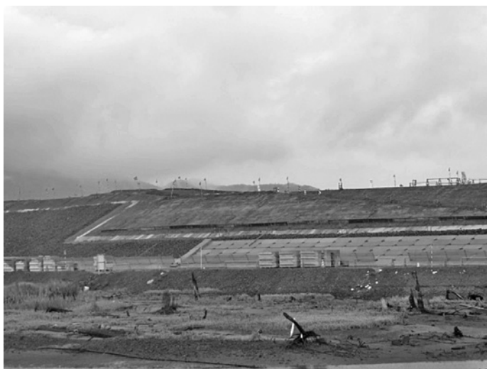
写真3 高田松原における防潮堤建設。大規模な土地改変が行われている（筆者撮影）
