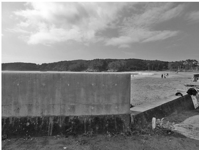
写真2 宮城県気仙沼市気仙沼大島にある小田の浜。住民の猛反対によって、宮城県の示した11.8mの防潮堤が原形復旧（3.5m）に留められた数少ない事例。ただし、県は地盤沈下を理由に1mのかさ上げを求めており、かさ上げる場所や方法などをめぐって、2015年8月現在、合意はできていない。写真のように、すでに部分的にかさ上げされた箇所があるが、道路からは海が見えなくなる。小田の浜は、環境省の快水浴場百選に選ばれ、国立公園第二種特別地域に指定されている（筆者撮影）
