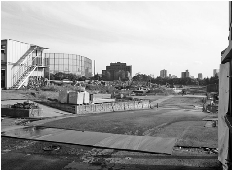
写真 2 解体作業中の国立競技場（著者撮影）
