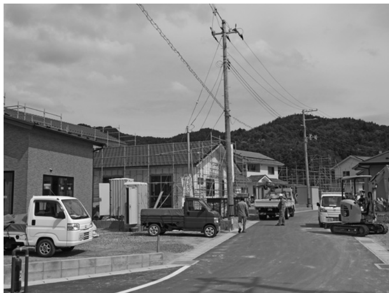
写真2 住宅の建築が進む気仙沼市舞根地区の高台移転地（2015年9月に筆者が撮影）
