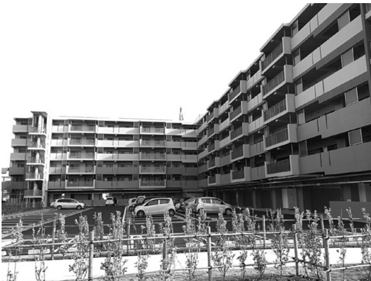
写真1 気仙沼市南郷地区の災害公営住宅（2015年3月に筆者が撮影）
