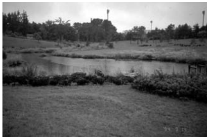
写真2 北海道帯広市洪水調整池
