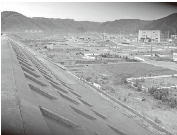
写真2 白くきれいだった巨大なコンクリートの防潮堤は灰色に変色して汚くなり、背後の家々は3.11の津波でほとんど流されてしまった（撮影安田喜憲）
