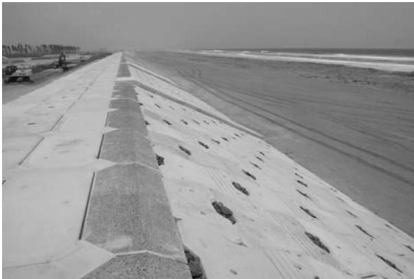
写真1 仙台平野の海岸に完成した立派なコンクリートの防潮堤。建設直後は白くてきれいだが、数年もたつと汚く汚れてくる（撮影安田喜憲）
