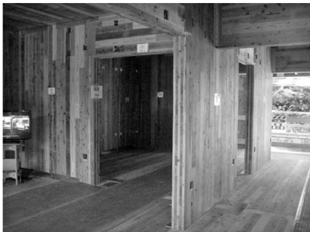
写真2 CLTによる躯体 くたい
