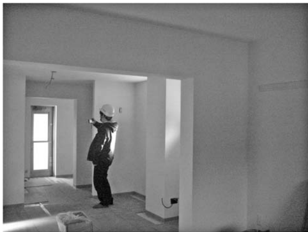
写真3 内装仕上げで躯体は分からない
