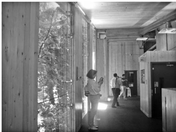
写真4 CLTを用いたバイオマス発電施設(カナダ)
