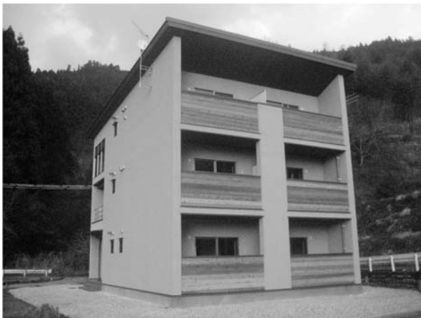
写真 1 CLT を用いた社員寮 (外観からは木造かどうか分からない)
