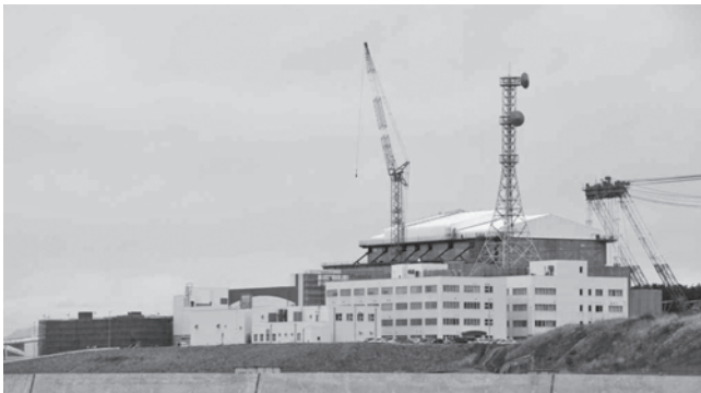
写真 1 青森県で建設中の大間原発＝2014 年 12 月
