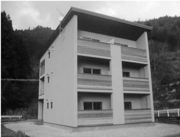
写真 1 CLT を用いた社員寮
