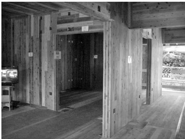
写真2 CLTによる<sup>くたい</sup>躯体
